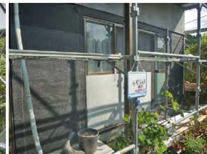
▲下地防水紙、ラスの設置
