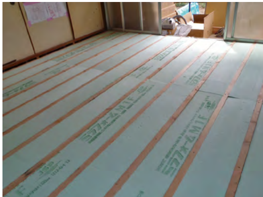
▲ボード状断熱材敷き込み（床補修と同時に行う場合）
