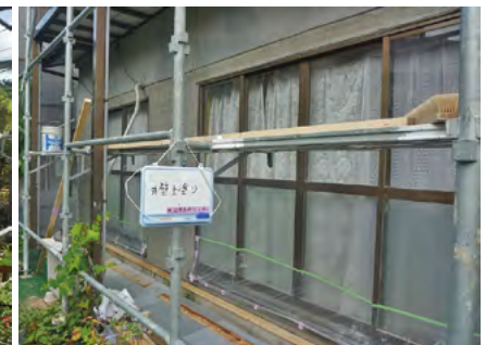
▲モルタル補修完了
