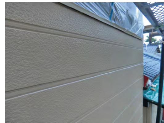
▲張り替え完了
