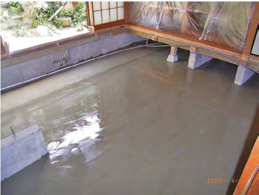
▲コンクリート打設完了
