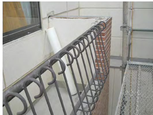
▲笠木破損部分撤去
