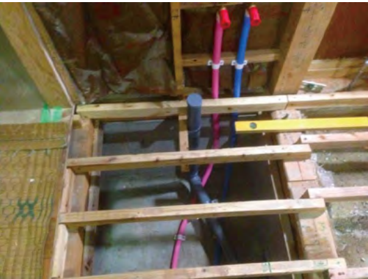
▲配管中（立上り部）
