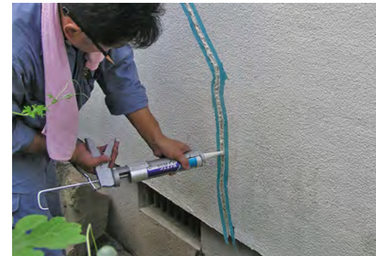
▲シーリング施工中
