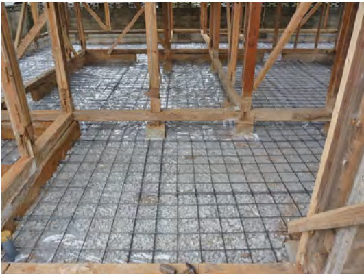
▲ポリフィルム敷きこみ、配筋
