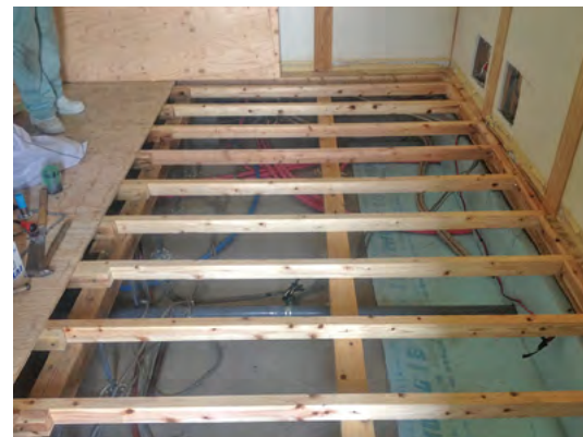
▲クッションフロアー及び合板撤去、根太の確認
