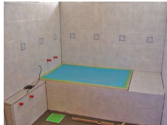
▲床タイル貼り替え状況
