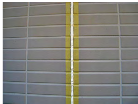
▲シーリング完了
