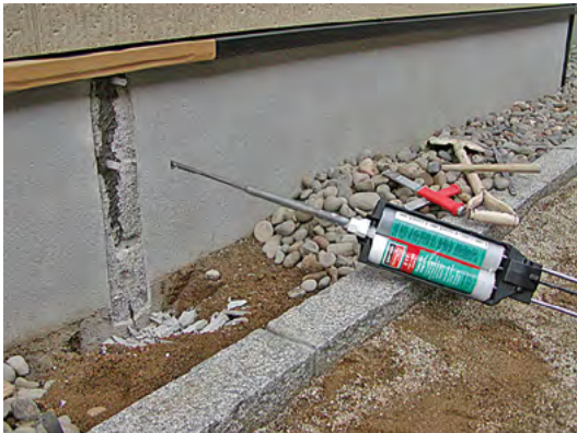
▲ひび割れ部分のモルタル撤去
