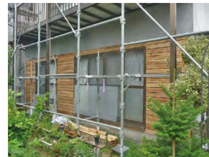
▲下地撤去状況
