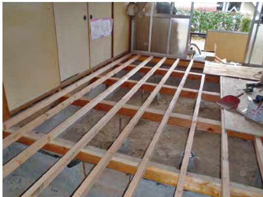
▲土台施工（床補修と同時に行う場合）
