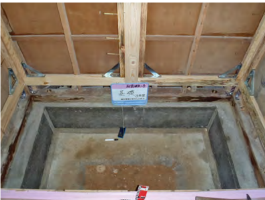
▲増し打ち完了
