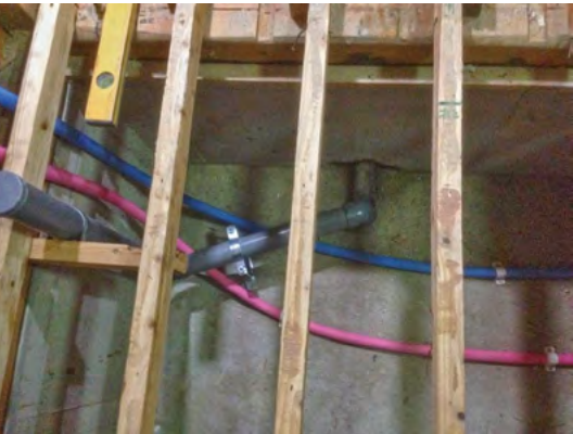
▲配管中（床下部）
