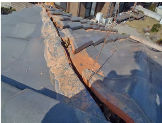
▲がんぶり瓦を撤去
