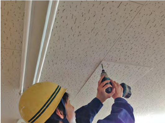
▲化粧ボード留め付け
