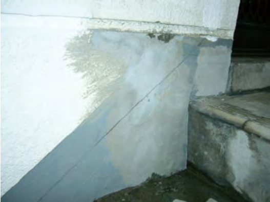
▲樹脂モルタル完了
