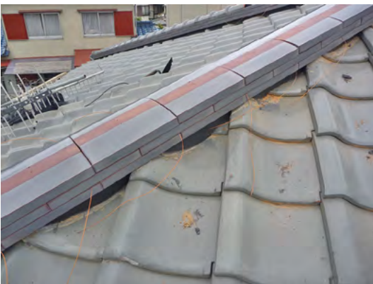
▲棟の取り直し完了
