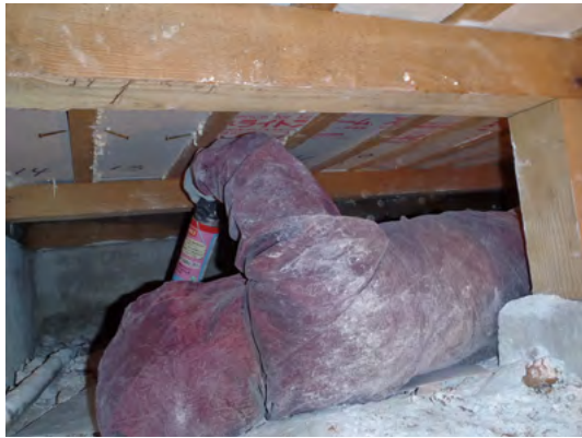
▲ボード状断熱材設置中
