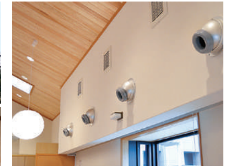
▲地中熱利用換気システム 外気を地中7mまで埋設した杭に取り込み、年中一定温度の地中で温度調節し、室内に取り込みます。
