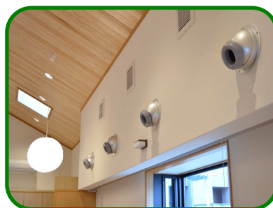
地中熱利用換気システム
