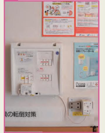
地震の揺れに反応してブレーカーが自動で落ちる機器を展示しています。
