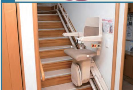
座った状態で階段を上下に移動できる装置を展示しています。
