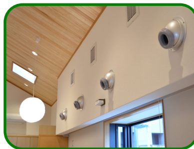
地中熱利用換気システム
