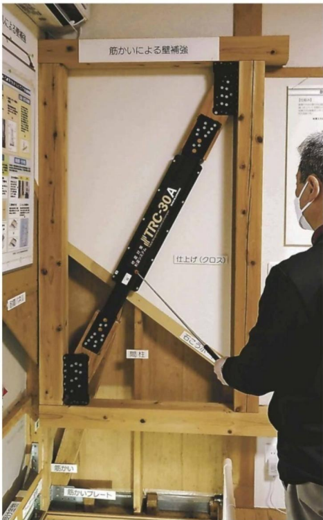
筋交いを入れて壁を補強するのが対策の一つ。ここでは建物の振動エネルギーを吸収し、変形を抑える制震ダンパーも併用されている ＝福岡県春日市の生涯あんしん住宅
