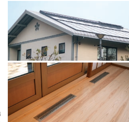
▲空気集熱式パッシブソーラーシステム 外気を屋根上の集熱パネルで温めて室内に送り出します。太陽光発電量をパネルで見ることができます。
